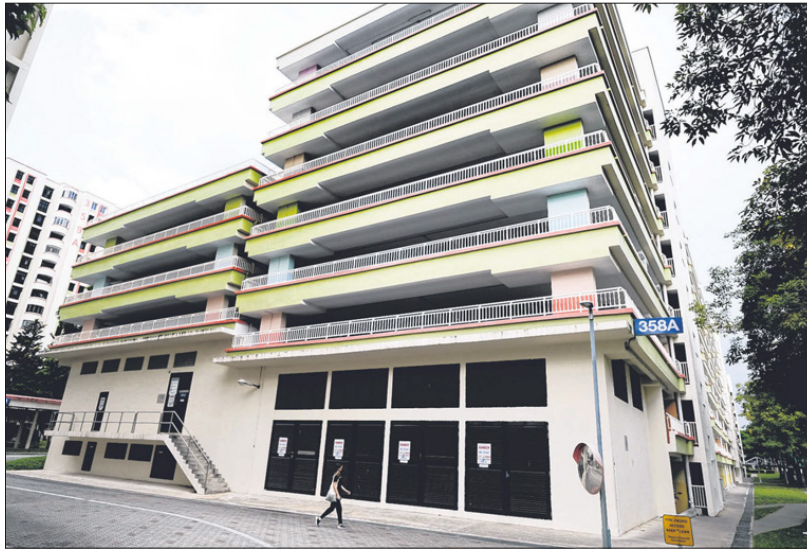
由于电动车充电需求越来越大，陆交局将翻新住宅区的电力设施。在这之前，当局将在数十个电力设施展开工程研究，包括这个在三巴旺一座多层停车场底层的电力站。（曾坤顺摄）
